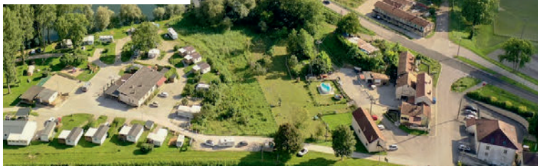
Vue aérienne du Camping de l'île à Ranchot
